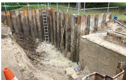
汚染土壌の掘削除去工事(旧東洋インキSCホールディングス(株)先端材料研究所)
